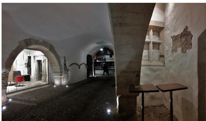
A Vallásszabadság házának kibontott ívei a kapualjban és a megtalált keresztosztós ablak a középkori lépcső alatt
